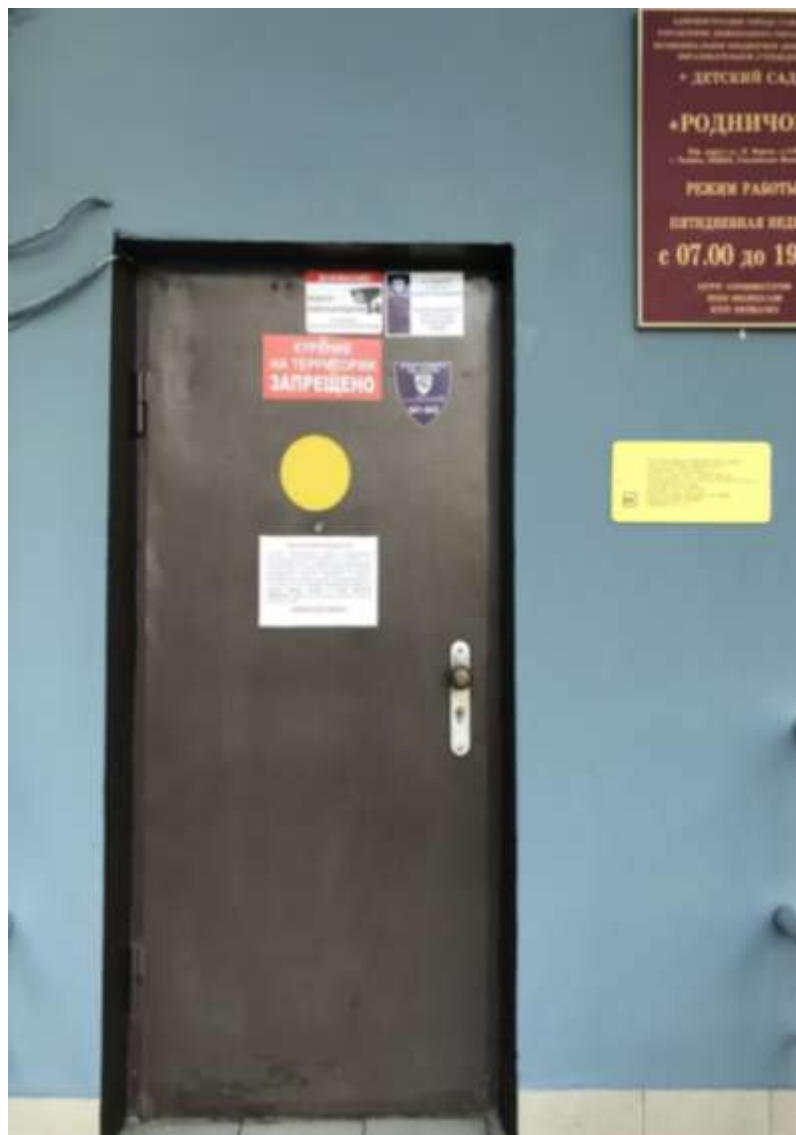
Фото №11. Дверь (входная)
