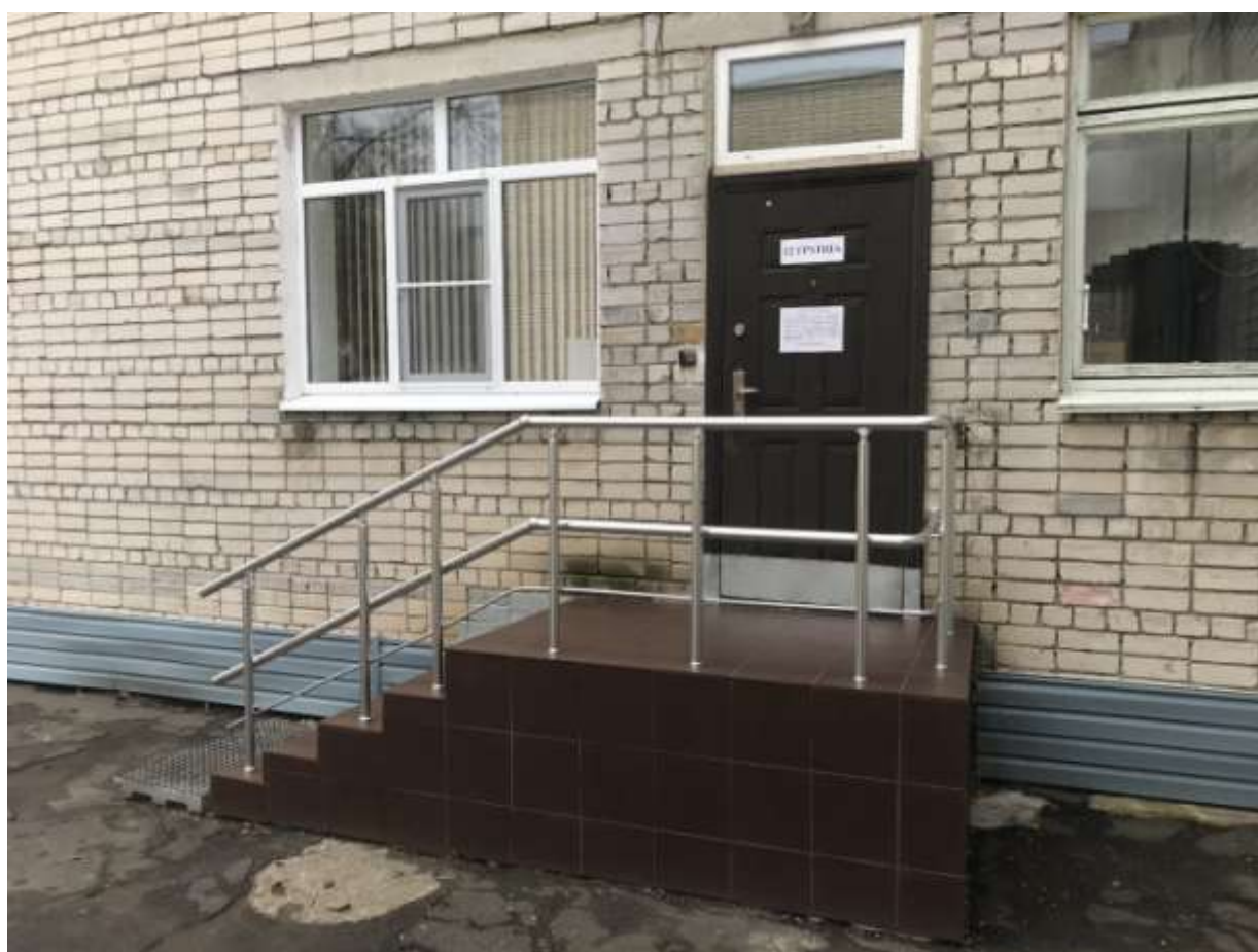
Фото №23. Пути эвакуации (в т.ч. зоны безопасности)
