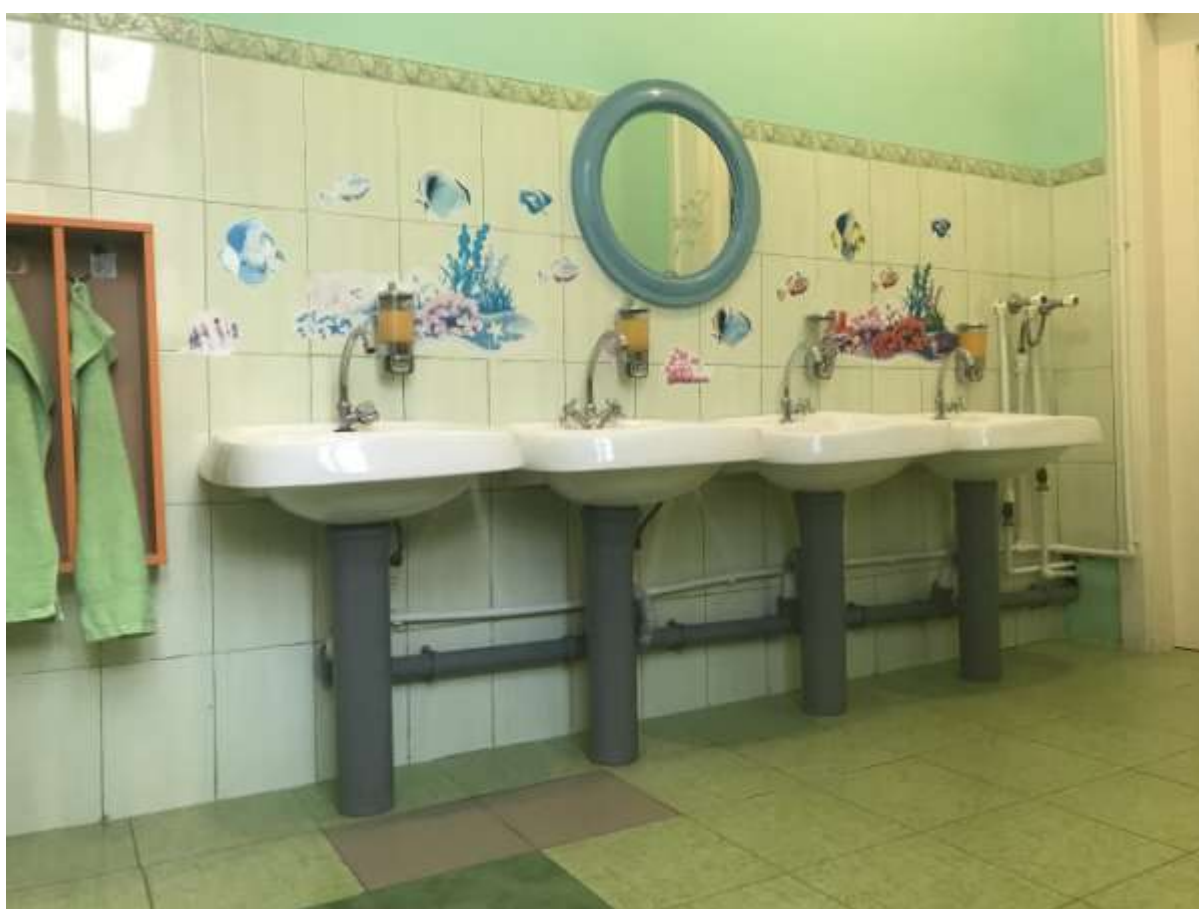
Фото №37. Туалетная комната
