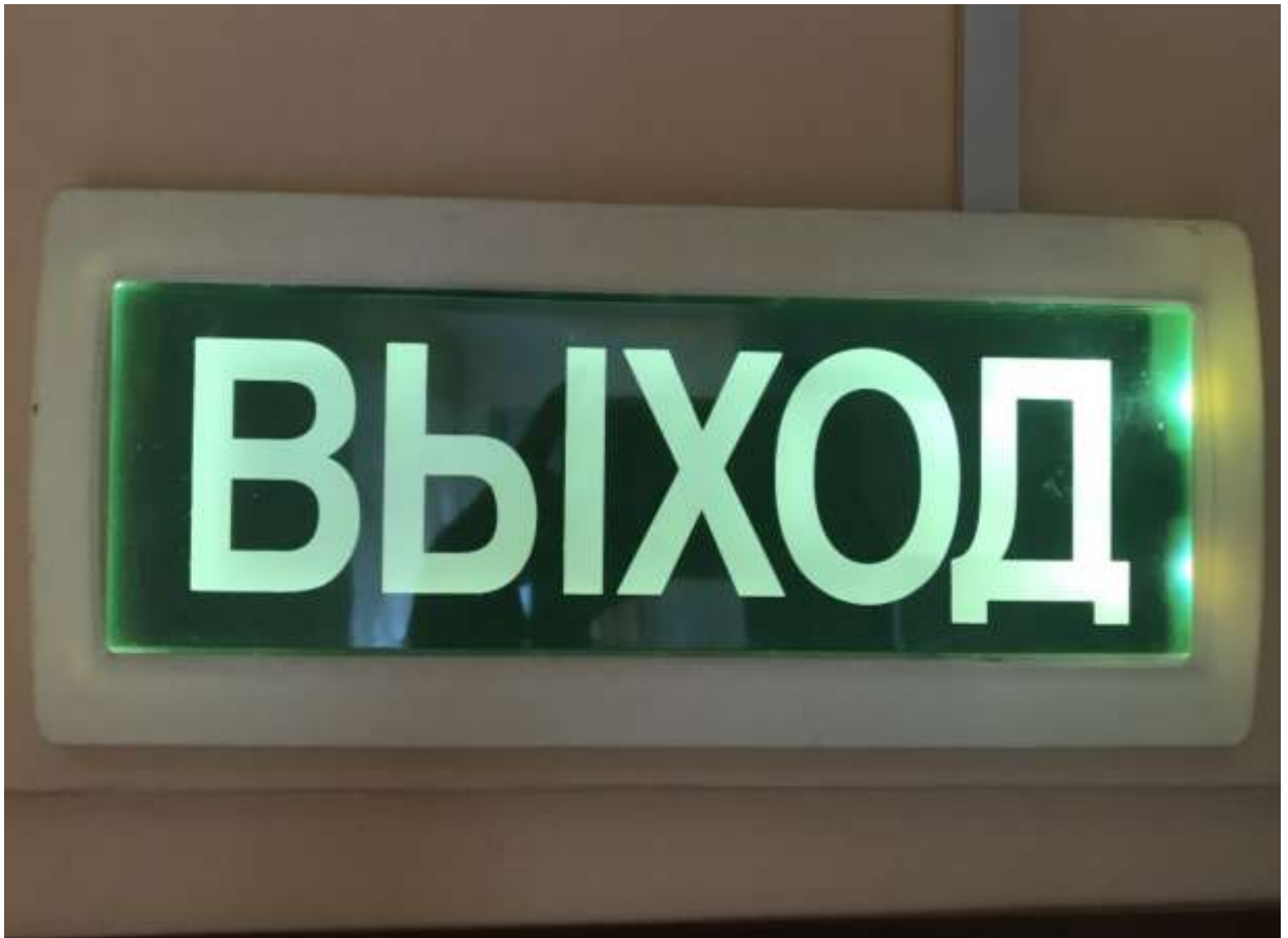
Фото №26. Пути эвакуации (в т.ч. зоны безопасности)
