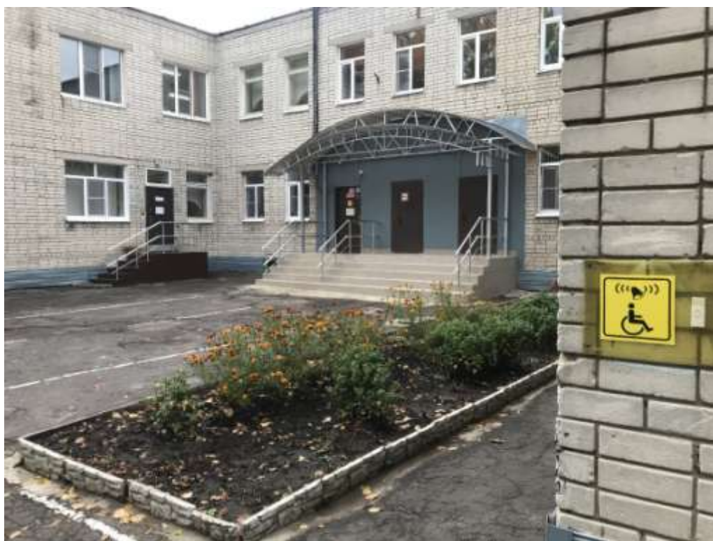
Фото №8. Вход (входы) в здание
