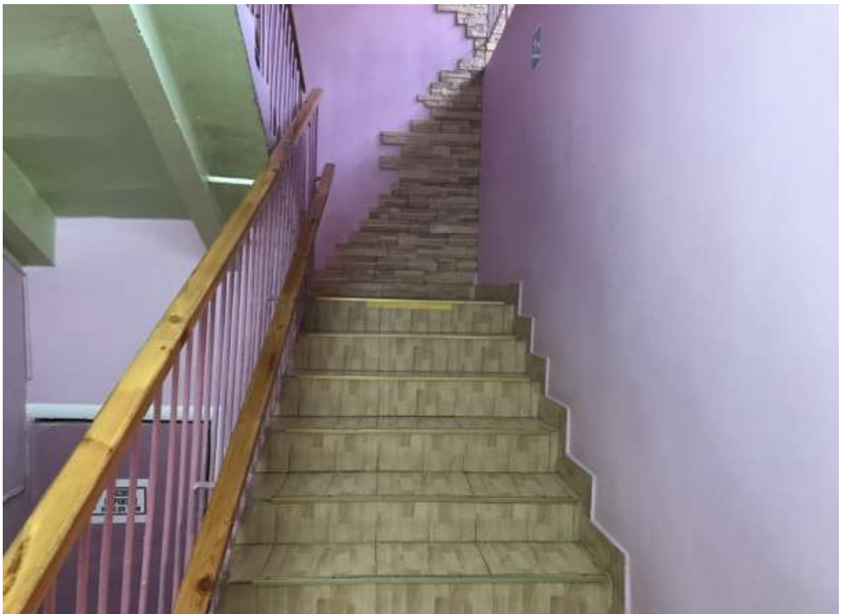
Фото №17. Коридор (вестибюль, зона ожидания, галерея, балкон)
